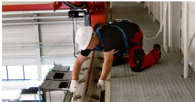
Einmal an das System angeschlagen, kann sich der Monteur auf dem Steg ungehindert und frei in alle Richtungen bewegen
