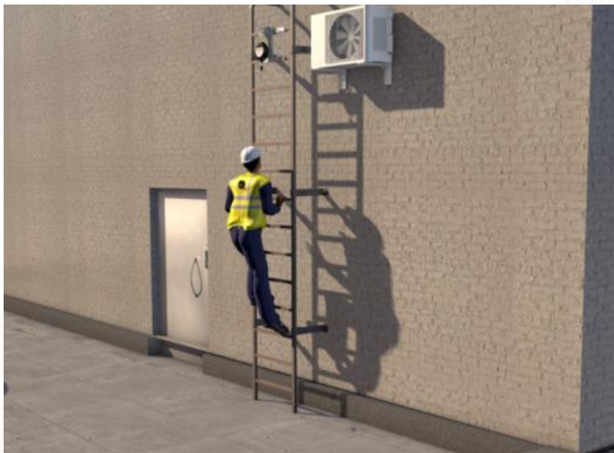
„Fest montierte Leiter mit Anschlagpunkt ABS LaddAnchor gesichert.“
