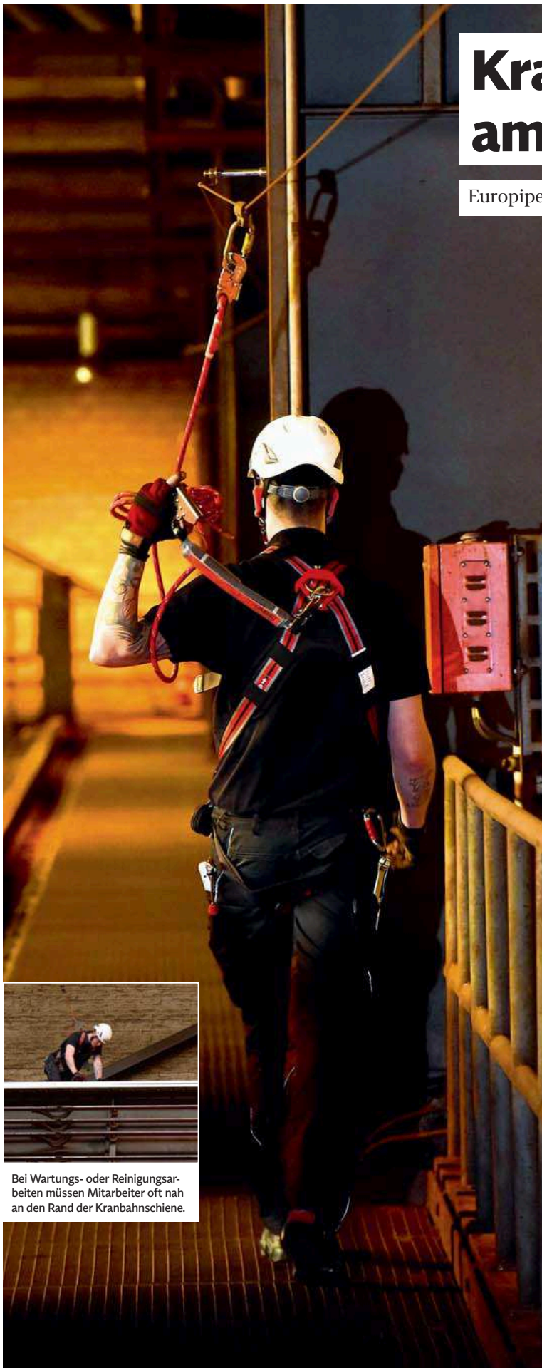
Mit dem auf Rückhalt gespannten Verbindungsmittel wird einem Fehltritt über die Absturzkante vorgebeugt.
