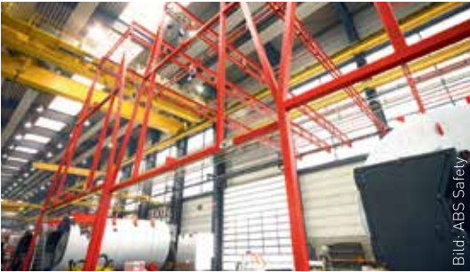
Optimal zwischen Kranbahn und Fertigungsstraße eingepasste Absturzsicherung.
