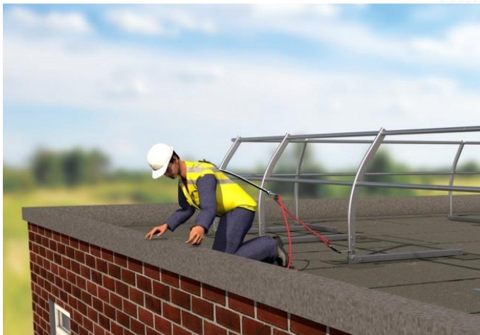
„Schutzgeländer mit integriertem Anschlagpunkt ABS-Lock Guard.“
