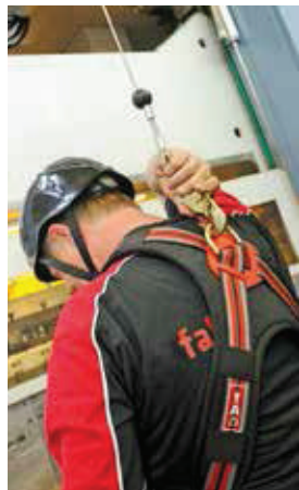
Das Herz der PSAgA ist der Auffanggurt. Dank Rückenöse und Höhensicherungsgerät über dem Kopf ist in diesem Fall kein Verbindungsmittel bei der Arbeit im Weg.
