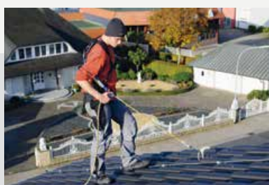
ARBEITSSICHERHEIT Handwerker am Haken
