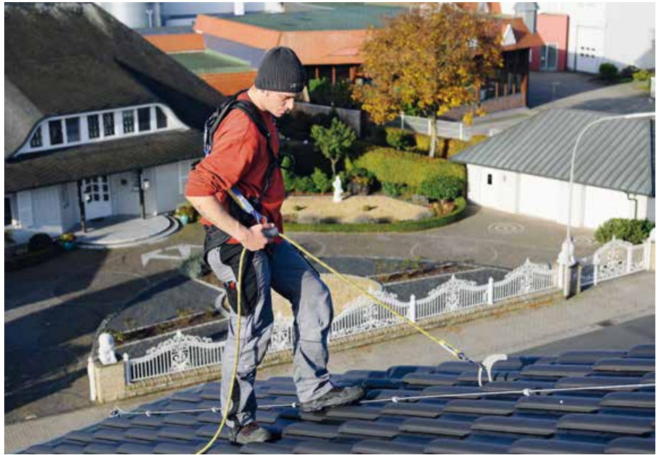
▲ Lebenswichtiger Platz zum Arbeiten: Wartungswege sollte der Dachdecker bei der Installation einer neuen Photovoltaikanlage unbedingt einplanen
